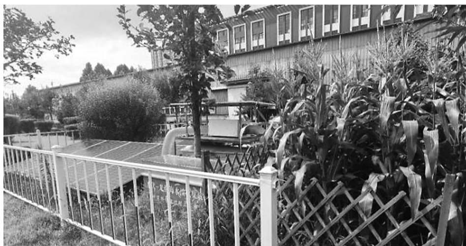
廊坊工程试验基地的光伏-光热海水淡化设备及灌溉试验田。科研团队供图
