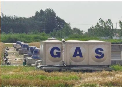
GAS 地上部分外观。
