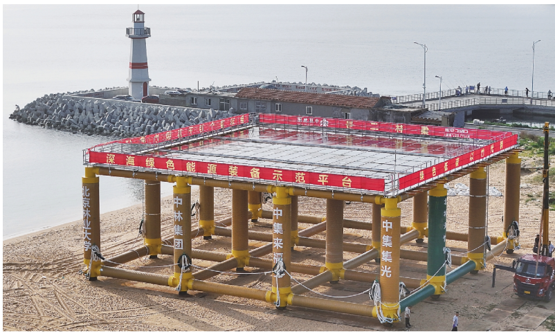
7 月 25 日,全球首个百千瓦级竹基海上光伏平台“集林二号”完工并准备下水。该平台主体结构采用“竹缠绕管”和“海竹管”作为核心支撑构件,具备高强度、轻质化、耐腐蚀、可再生等优势,将安装于山东烟台海上光伏实证检测基地。
