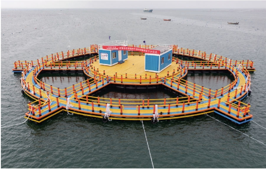
近海生态系统野外受控试验平台下水运行。
