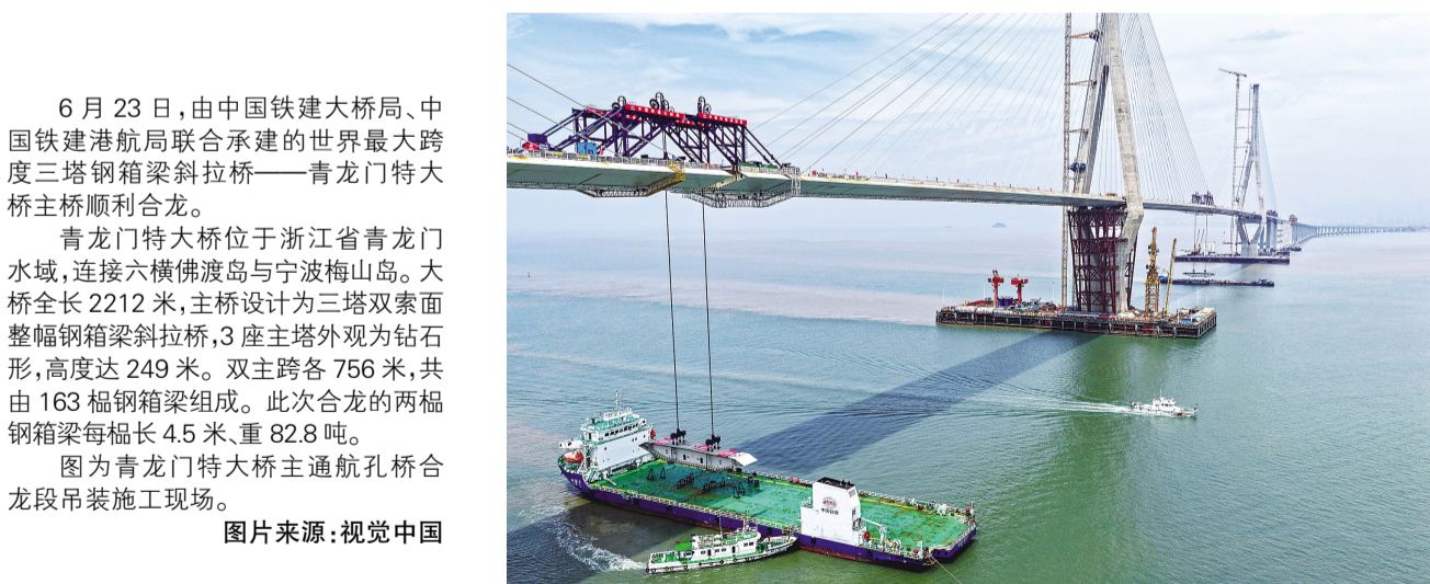
6月23日,由中国铁建大桥局、中国铁建港航局联合承建的世界最大跨度三塔钢箱梁斜拉桥——青龙门特大桥主桥顺利合龙。
