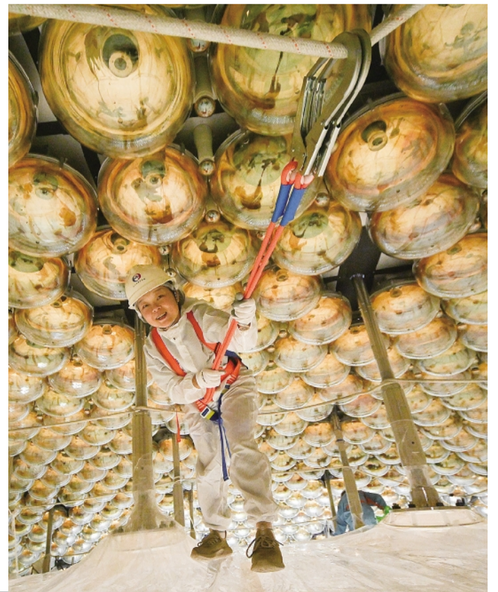
马骁妍在江门中微子实验探测器中检查安装质量。
