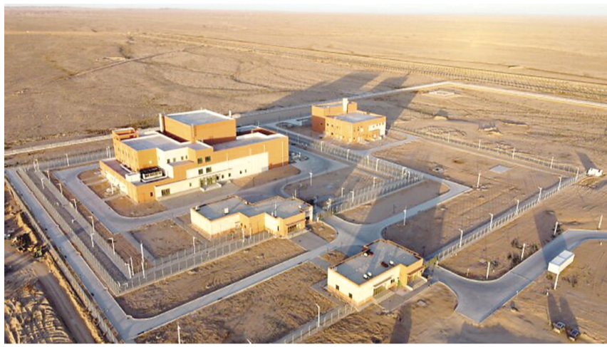
上海应物所武威园区钍基熔盐实验堆厂房航拍。
