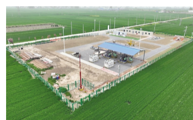
工程现场。受访单位供图
