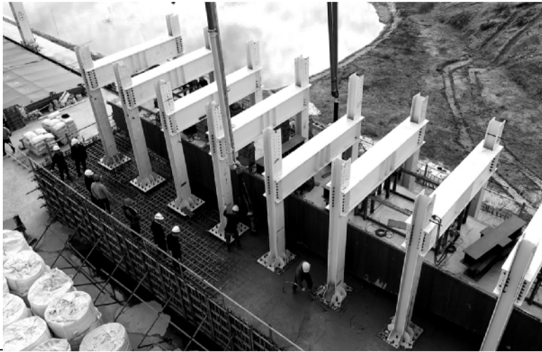
图中灰色船状设备是混凝土盖梁外壳。中交二航局供图
