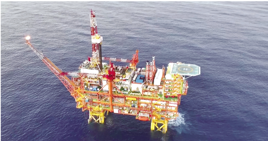
中国海油 9 月 10 日宣布,我国首个海上二氧化碳封存示范项目——恩平 15-1 油田封存项目累计封存二氧化碳突破 1 亿立方米,减少的碳排放量相当于植树 220 万棵,标志着我国海上二氧化碳封存技术、装备和工程能力已臻成熟。图为恩平 15-1 油田平台。图片来源:视觉中国
