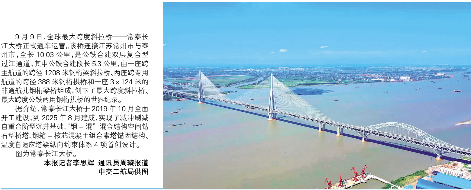
9 月 9 日,全球最大跨度斜拉桥——常泰长江大桥正式通车运营。该桥连接江苏常州市与泰州市,全长 10.03 公里,是公铁合建双层复合型过江通道,其中公铁合建段长 5.3 公里,由一座跨主航道的跨径 1208 米钢桁梁斜拉桥、两座跨专用航道的跨径 388 米钢桁拱桥和一座 3×124 米的非通航孔钢桁梁桥组成,创下了最大跨度斜拉桥、最大跨度公铁两用钢桁拱桥的世界纪录。
