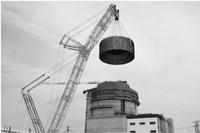
8月4日，国家电投山东海阳核电站3号机组核岛CB20模块顺利吊装就位，标志着该机组大型模块全部吊装完成，开始进入设备安装调试阶段。
