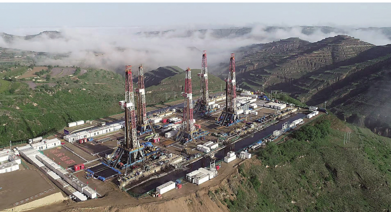
长庆油田庆城地区的钻井作业现场。 长庆油田供图
