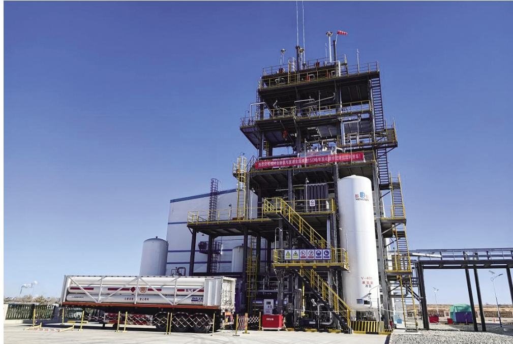
150吨/年固态储氢材料氢化镁中试项目现场。
