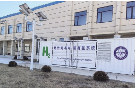
百千瓦级高效海水电解制氢系统。
