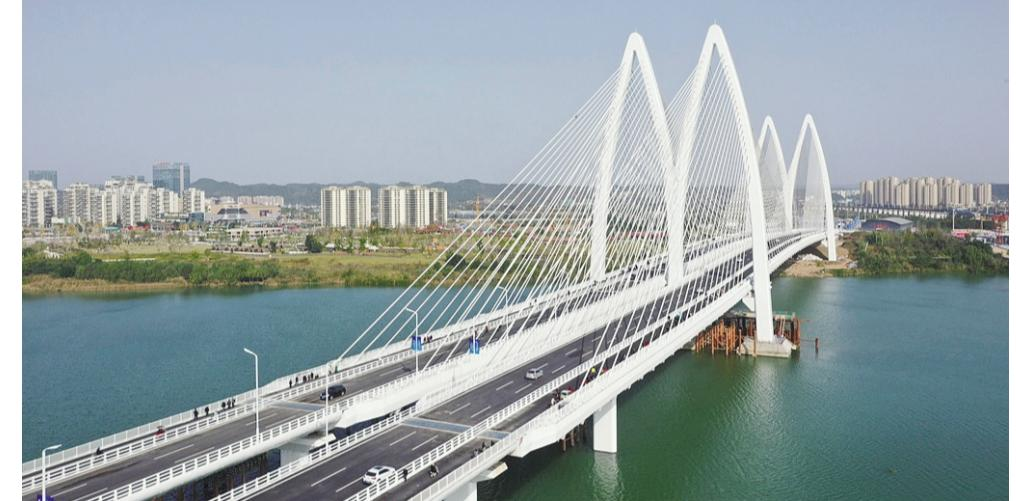
11月24日，四川遂宁涪江六桥建成通车。该桥全长约3.2公里，总投资约14.3亿元，是全国首座采用复杂曲线钢壳混凝土组合索塔的斜拉桥，创新运用双向抗滑鞍座钢绞线拉索技术，进一步增强了桥梁的抗震性能。
