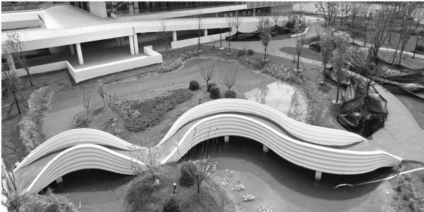
8月29日，一座造型别致的景观桥亮相南京市某高中。这是南京市首次采用3D打印技术在校内建设的多跨混凝土曲线桥。
