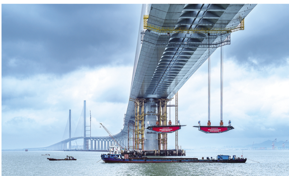
黄茅海大桥最后一根钢箱梁吊装现场。
