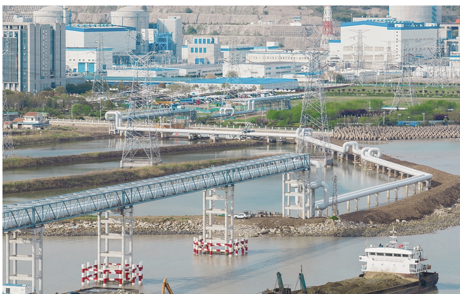
“和气一号”项目的蒸汽供能管道。
