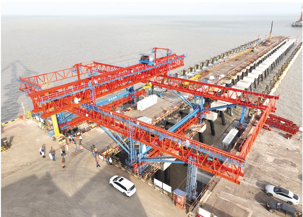
全球首创智能筑港机“首秀”现场。 中交二航局供图
