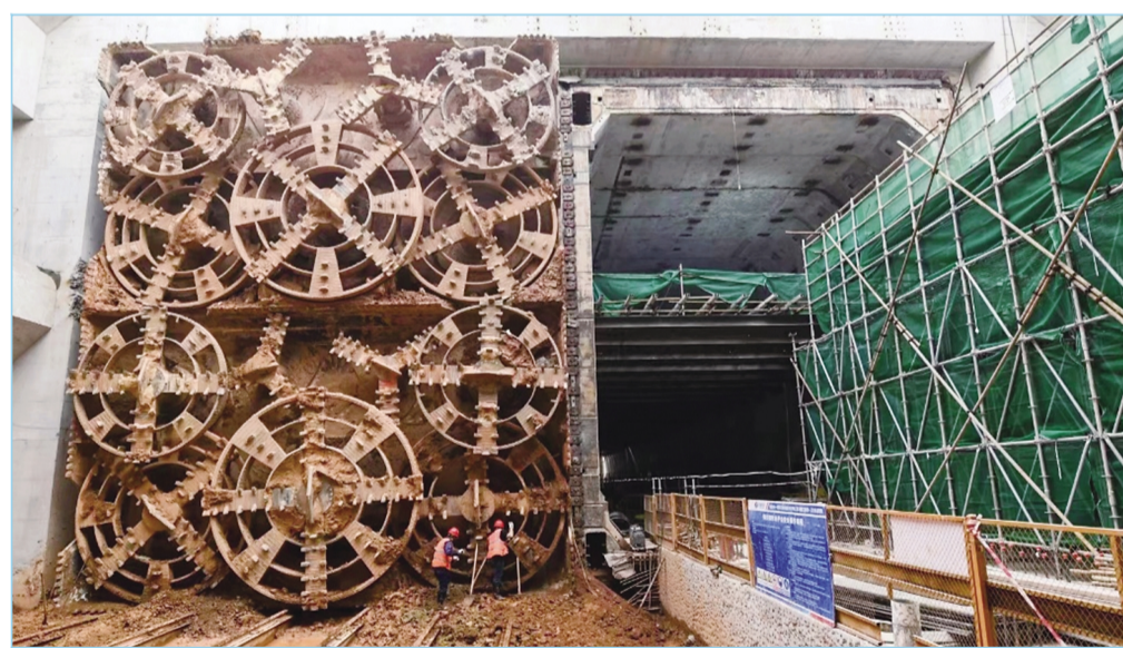
世界最大断面矩形顶管暗挖地铁站正式贯通。
