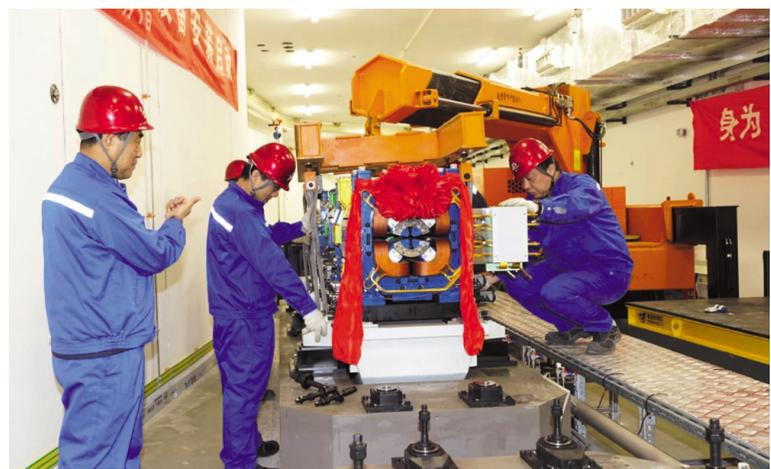
本报讯(记者倪思洁)近日,在位于北京怀柔的高能同步辐射光源(HEPS)储存环隧道里,HEPS工程总指挥潘卫民宣布,HEPS储存环隧道设备安装正式启动。随后,一段像火车头一样的储存环预准直单元,扎着红色绸带,缓缓卡进混凝土基座的卡槽。“火车头”长3米多、宽1米,载着8块磁铁,是HEPS储存环第一个预准直单元。这标志着HEPS加速器更多、更精密的设备开始安装,HEPS进入了更广泛和更深层次的攻坚阶段。HEPS是中国科学院、北京市共建怀柔科学城重大科技基础设施集群的核心设施,主要由加速器、光束线及实验站构成。未来一年,288个这样的预准直单元将像这段“火车头”一样,围出一个长达1300多米的加速器环,环内面积约20余个足球场。届时,它将成为世界上第三大光源加速器,国内第一大加速器。中科院高能物理研究所供图
