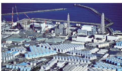
放射性废水目前储存在福岛核反应堆附近1000多个罐中。图片来源:THE ASAHI SHIMBUN VIA GETTY IMAGES
