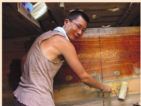
▲2007年，许路在“太平公主号”建造工地给船舱刷桐油。 林植摄
