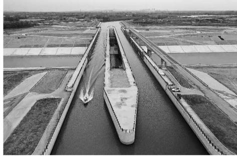
这是9月23日拍摄的通航后的引江济淮淠河总干渠渡槽(无人机照片)。 近日,由中铁四局参建的引江济淮淠河总干渠渡槽通航。从空中俯瞰,淠河总干渠从引江济淮运河上凌空而过,呈现出河上有河的"水上立交"景象。据了解,淠河总干渠比引江济淮航道高出30多米,通过架设渡槽,淠河水从引江济淮运河"跨过",形成一座河上有河可通水行船的"水桥"。
