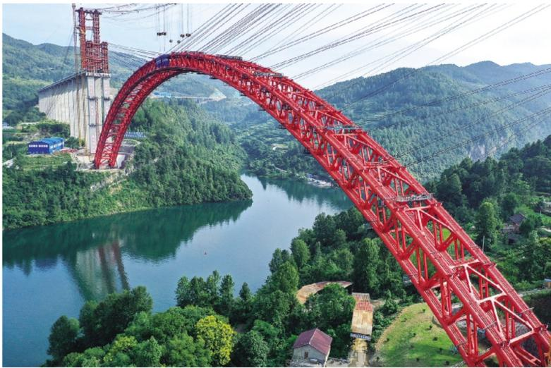
8月15日,贵州铜仁,航拍主拱合龙的乌江特大桥(无人机照片)。当日,随着最后一块合龙段板焊接完成,由中交一公局第四工程有限公司承建的贵州德(德江)余(余庆)高速公路乌江特大桥主拱正式合龙。
