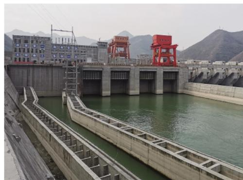
1 月 16 日,湖北十堰,在孤山航电枢纽发电厂右侧,一条千米生态鱼道正在建设中。
