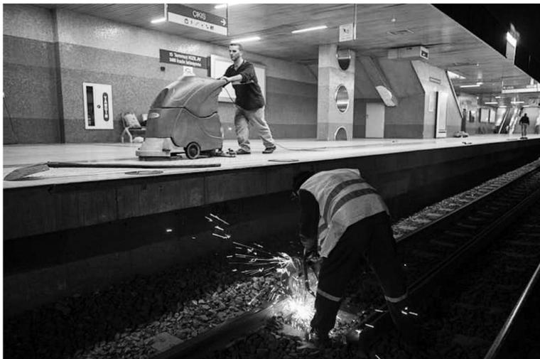
土耳其安卡拉的一名地铁夜班工人正在使用金属切割机。
