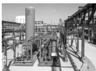
北京冬奥会氢气新能源保供项目现场
