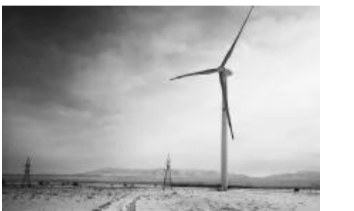
位于哈萨克斯坦的金风科技奇利克(Shelik)项目现场
