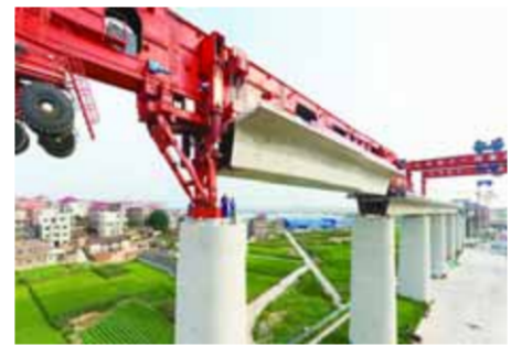
我国首台1000吨级高铁箱梁运架一体机投入使用。 新华社发
