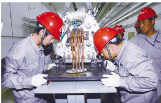
2014年10月15日,中国散裂中子源首台设备负氢离子源下隧道安装。中科院高能所东莞分部供图
