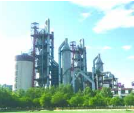
宁夏胜金 2500 吨/天低 NO x 排放水泥窑炉示范工程
