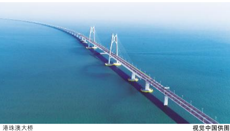
港珠澳大桥 视觉中国供图
