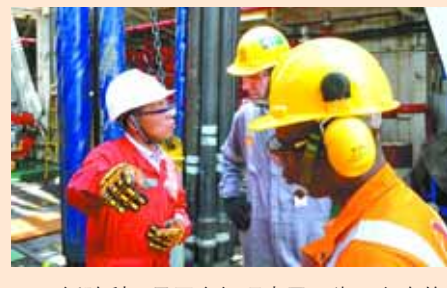
新胜利一号平台经理李恩朋为甲方壳牌总部检查团介绍平台现场施工情况。杨杰摄
