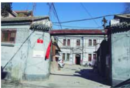
北京西四南大街兵马司胡同15号(原9号)内的中国地质调查所旧址,面对大门的是两层楼的地质调查所图书馆。
