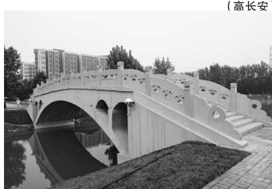
矗立在河北工业大学北辰校区的装配式混凝土3D打印赵州桥
