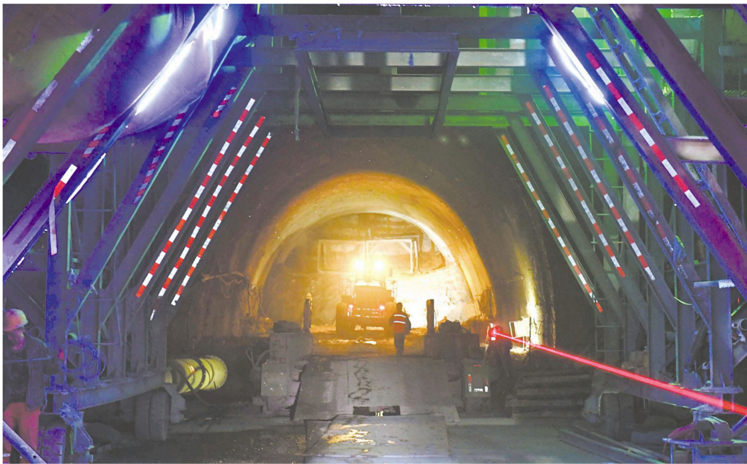
1月2日,中铁十八局集团的施工人员在太尖山隧道内施工。目前,玉磨(玉溪—磨憨)铁路重点工程太尖山隧道工程施工进展顺利。据悉,玉磨铁路起于云南省玉溪市,途经普洱市、西双版纳傣族自治州,止于磨憨口岸,全长508公里,是我国通往老挝、泰国国际铁路通道的组成部分。 新华社记者杨宗友摄
