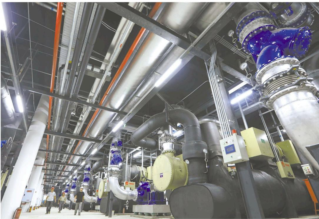
8月14日,技术人员在江水源1号能源站地下车间巡查设备运行情况。江水源热泵集中供冷供热系统1号能源站已稳定试运行2个月,重庆市江北嘴CBD商业中心400万平方米公共建筑享受着“水空调”利用江水带来的清凉。江北嘴CBD位于长江、嘉陵江交汇处,由于使用了集中供冷供热,这里虽然高楼林立,却没有一台空调外机。“水空调”是指利用江水水温比较稳定的特点,通过开发淡水源热泵技术,用电力将江水汇集到热泵中转换,使之形成一种空调系统。与传统空调相比,绿色环保的“水空调”不仅避免了噪音、热排放、空气污染等弊端,还比传统空调节能30%以上。新华社记者刘潺摄
