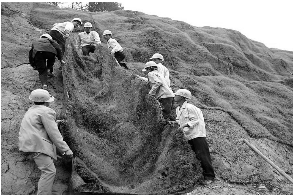
无土生态护坡草毯铺装
