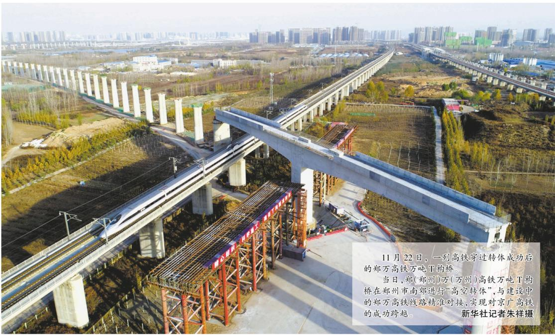
11月22日,一列高铁穿过转体成功后的郑万高铁万屯T构桥。当日,郑(州)万(州)高铁万屯T构桥在郑州市南郊进行“高空转体”,与建设中的郑万高铁线路精准对接,实现对京广高铁的成功跨越。新华社记者朱祥摄
