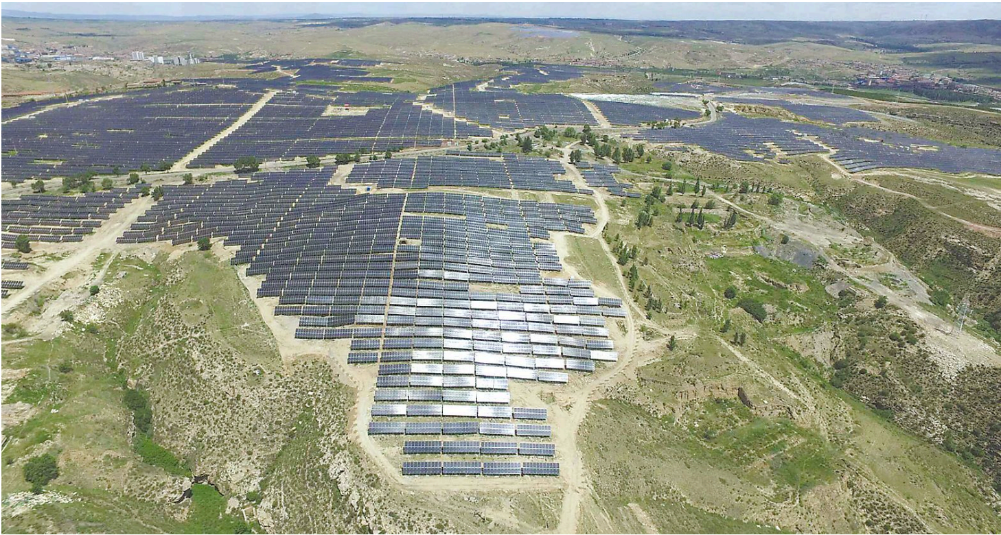
中国首个光伏“领跑者”示范项目山西大同采煤沉陷区国家先进技术光伏示范基地自 2016 年 6 月并网发电以来，累计发电 9732.92 万千瓦时，月均发电量达 648.8 万千瓦时，高出常规电站 20%。据悉，该项目总占地面积 185.7 公顷，为 50 兆瓦先进光伏技术产品应用基地，可解决当地 3.7 万个中等家庭日常用电。该基地光伏组件由英利绿色能源控股有限公司提供。图为近日航拍的该示范基地的一景。
