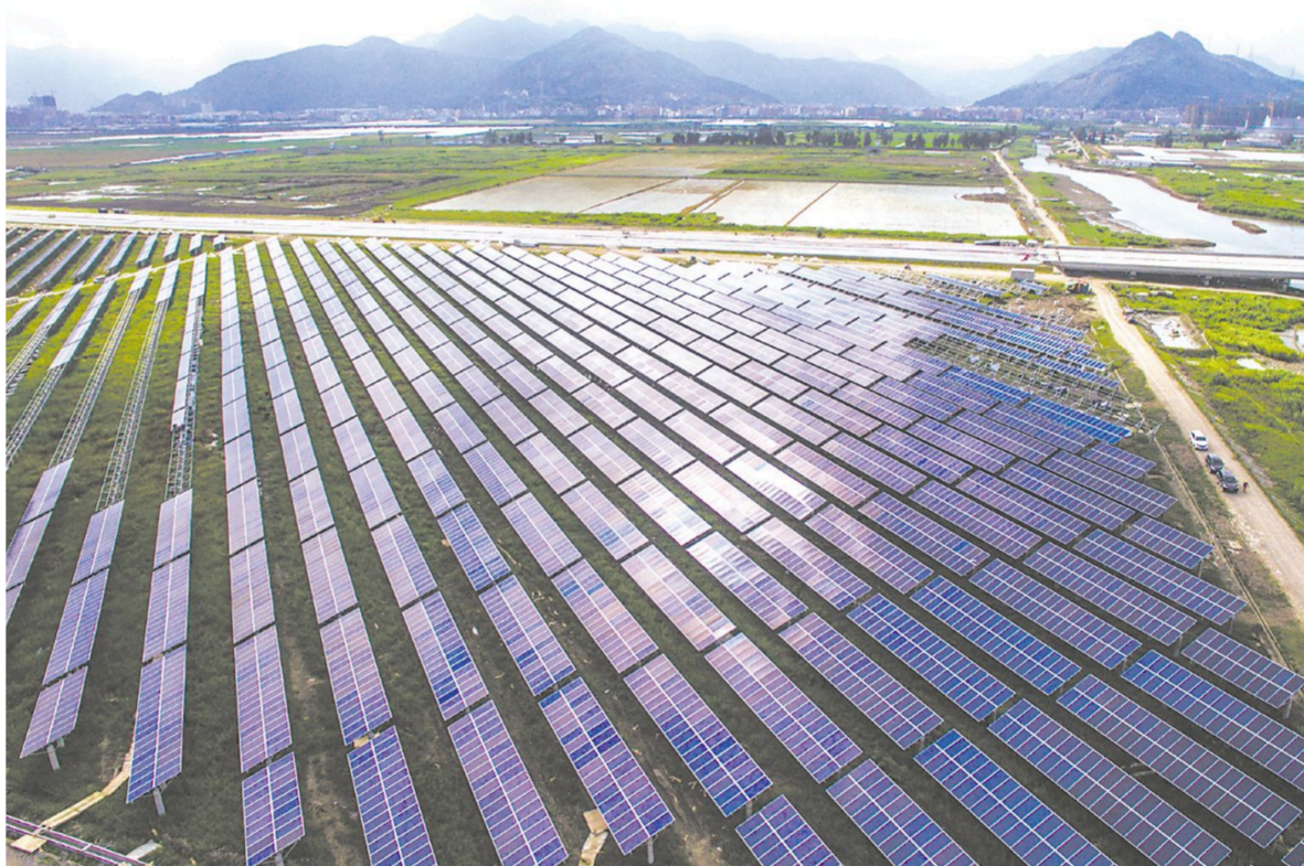
空中俯瞰乐清市乐成镇胜利塘农田里已经基本建成的“农光互补”光伏发电项目(8月2日报)。浙江省乐清市正泰150兆瓦“农光互补”光伏发电项目是乐清市2016年重点项目之一,预计将于8月底并网发电。该“农光互补”发电项目通过在光伏板下种植农作物及名贵中药材的方式,提高土地利用效率,实现光伏发电与生态种植的有机结合。据当地电力部门预计,该农光互补光伏发电项目并网后,每年将为温州当地电网提供1.4亿千瓦时的清洁电量。新华社记者徐思摄
