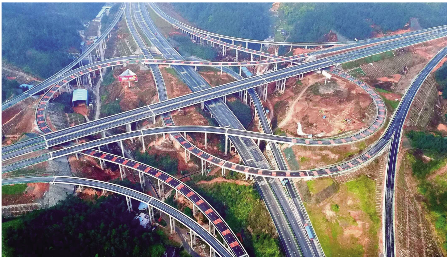
1月17日航拍的连接沪渝、恩黔、恩来、恩建等高速公路的罗针互通桥梁。
