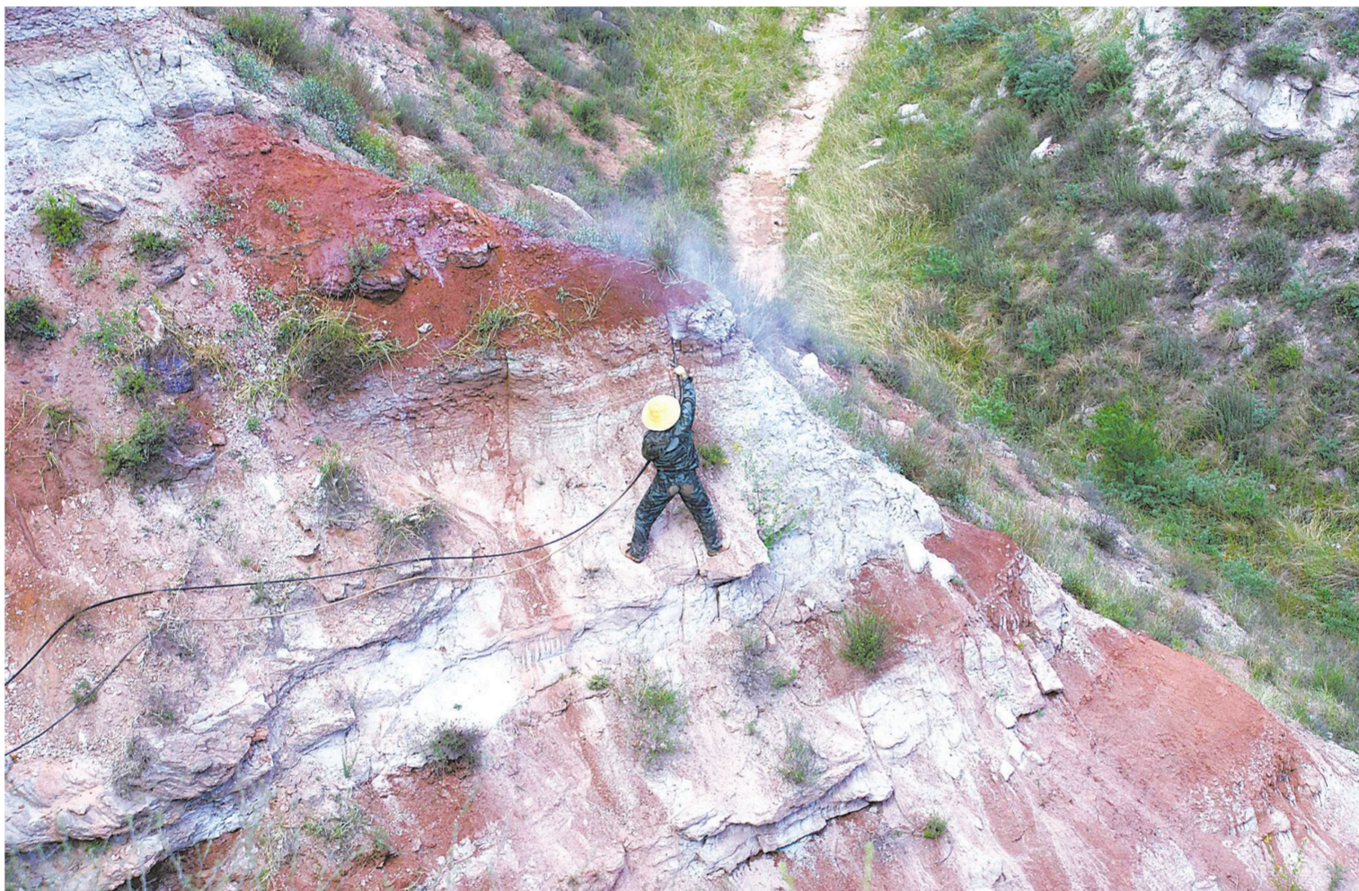
内蒙古鄂尔多斯,工人正沿着专门开辟的施工便道,在砒砂岩坡面上进行抗蚀材料的喷洒。
