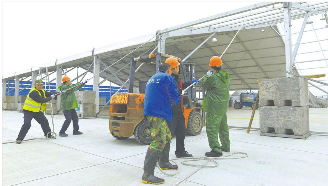
3月18日,在南京禄口国际机场停机坪内,工人们在搭建“阳光动力2号”太阳能飞机的停放帐篷。目前,搭建中的帐篷即将完工,帐篷为全钢结构,可抵御大风,将用于停放和展览飞机。“阳光动力2号”太阳能飞机是由一批致力于环保事业的科学家、工程师和探险家研发的一架完全由太阳能驱动的飞机,翼展达72米。
