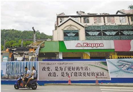
6月21日拍摄的“中国—东盟河口国际旅游文化景观长廊”施工拆除区域。图片来源:百度图片
