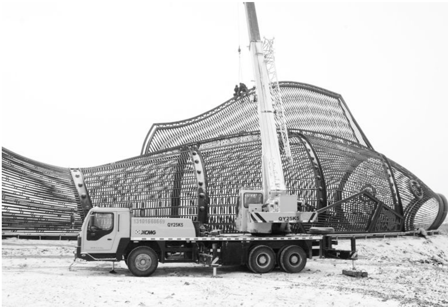
12月4日,哈尔滨冰雪大世界内,“中华有鱼”景观已初具规模。据了解,这条钢质“鲤鱼”长40米、宽10米、高13米,采用钢体外框,内置冰制滑梯,体量硕大,将以“世界最大的钢制鲤鱼”申报吉尼斯世界纪录。 CFP供图
