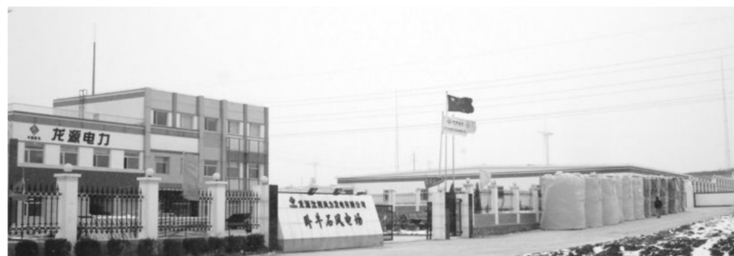
卧牛石风电场液流电池储能项目现场
