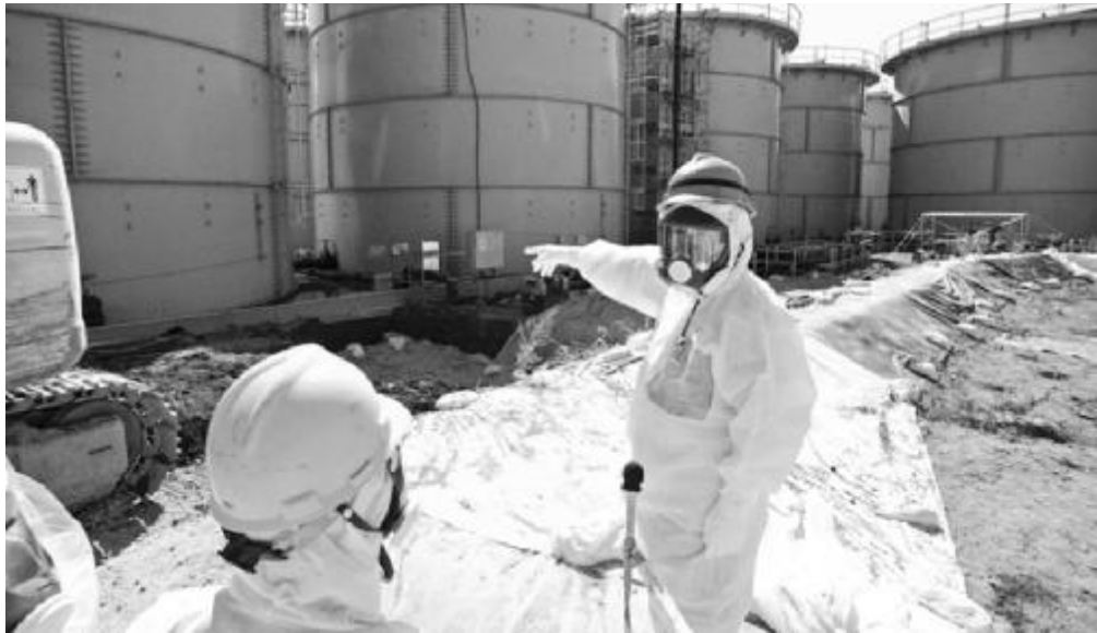
用来冷却福岛核电站 4 号反应堆的储水罐泄漏了数百吨高放射性污水。图片来源:Yomiuri Shimbun
